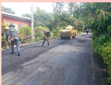
โครงการปรับปรุงซ่อมแซมถนนแอสฟัลท์คอนกรีตแบบ Over Lay สายทางบ้านท่ากุ่มวง หมู่ที่ 10
