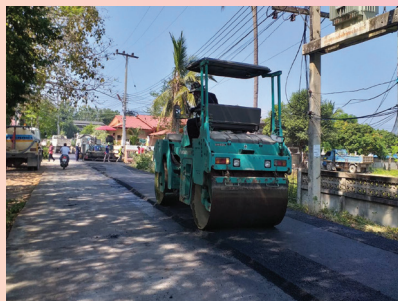
โครงการปรับปรุงซ่อมแซมถนนแอสฟัลท์คอนกรีตแบบ Over Lay สายทางบ้านโง้งมะค่า หมู่ที่ 16
