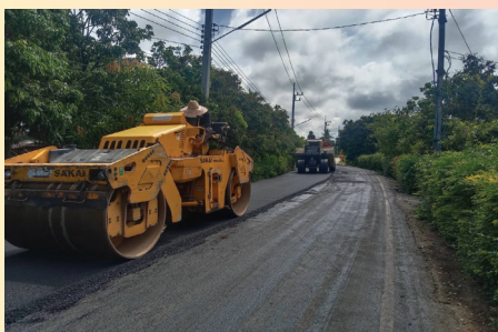
โครงการปรับปรุงซ่อมแซมถนนแอสฟัลท์คอนกรีตแบบ Over Lay สายทางบ้านท่ากุ่มวง หมู่ที่ 10
