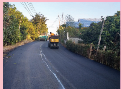
โครงการปรับปรุงซ่อมแซมถนนแอสฟัลท์คอนกรีตแบบ Over Lay สายทางบ้านโง้งมะค่า หมู่ที่ 16
