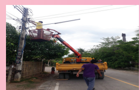
งานซ่อมแซมไฟฟ้าสาธารณะ/ไฟกิ่ง ภายในหมู่บ้าน
