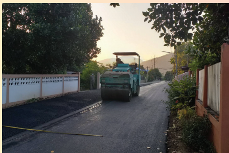
โครงการปรับปรุงซ่อมแซมถนนแอสฟัลท์คอนกรีตแบบ Over Lay สายทางบ้านโง้งมะค่า หมู่ที่ 16
