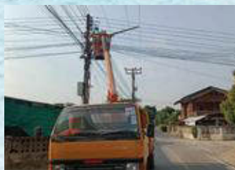
ซ่อมแซมไฟกิ่ง หมู่ที่ 9 บ้านวังตวง
