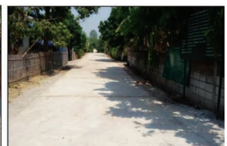
ถนน คสล. บ้านดงเย็นหมู่ 15
