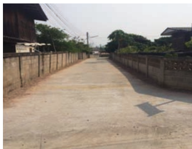
ถนน คสล.บ้านท่าข้าม ม.7
