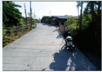
ถนน คสล.บ้านดงเย็น ม. 15
