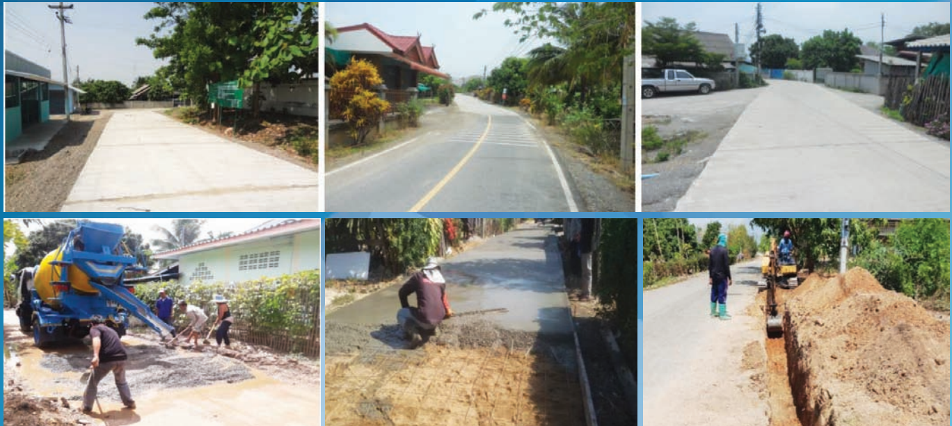
โครงการก่อสร้างถนนลาดยางภายในหมู่บ้าน
