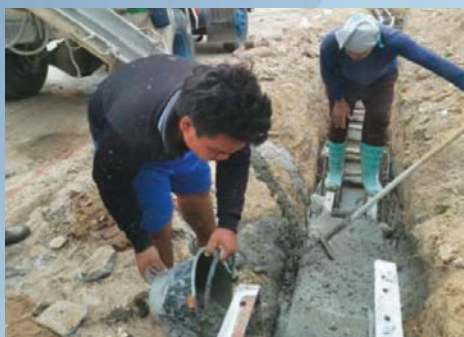
โครงการก่อสร้างท่อระบายน้ำ
