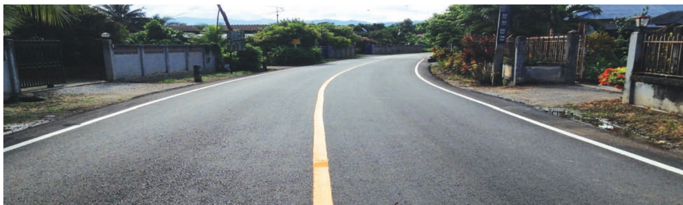
โครงการก่อสร้างถนนลาดยาง แบบโอเวอร์เลย์ บ้านสบแจ่มฝ่งขวา หมู่ที่ 8
